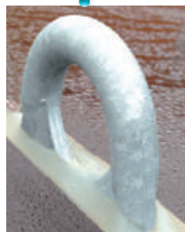
3 Anneau pour sangle de levage Hook for lifting strap
